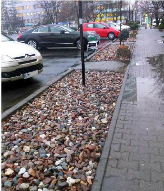
Rów infiltracyjny wykorzystany do odwodnienia parkingu, Wrocław (fot. E. Burszta-Adamak)
